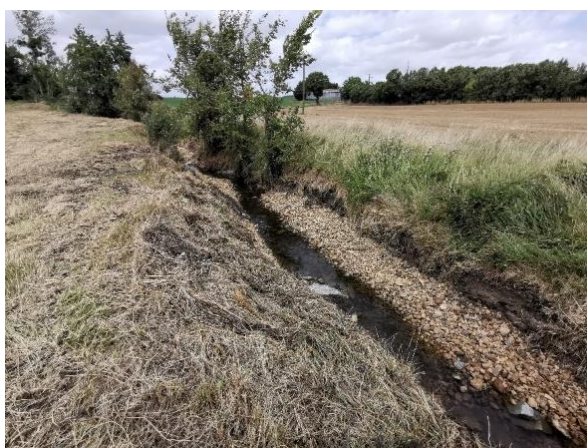
Recharge granulométrique réalisée sur la Loire (à gauche) et le Ris (à droite) afin de resserrer la section d'écoulement, restaurer l'armure sédimentaire et recréer des habitats aquatiques
