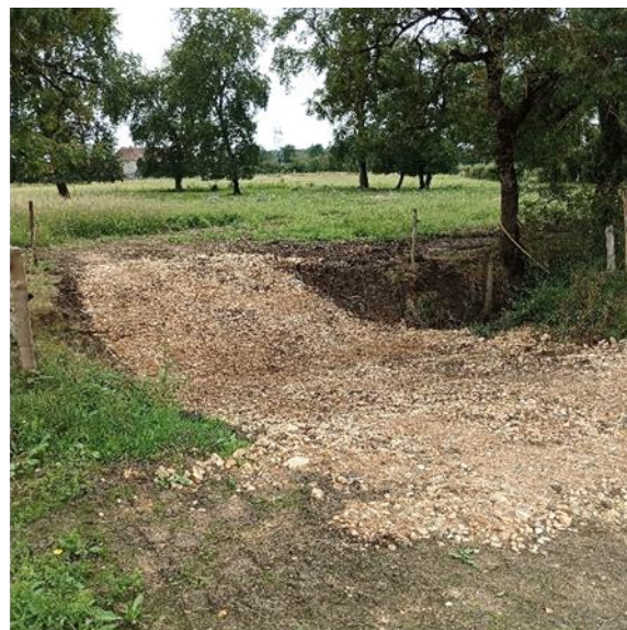
Aménagement d'un passage à gué stabilisé sur la Loire par le SYAGC en 2024
